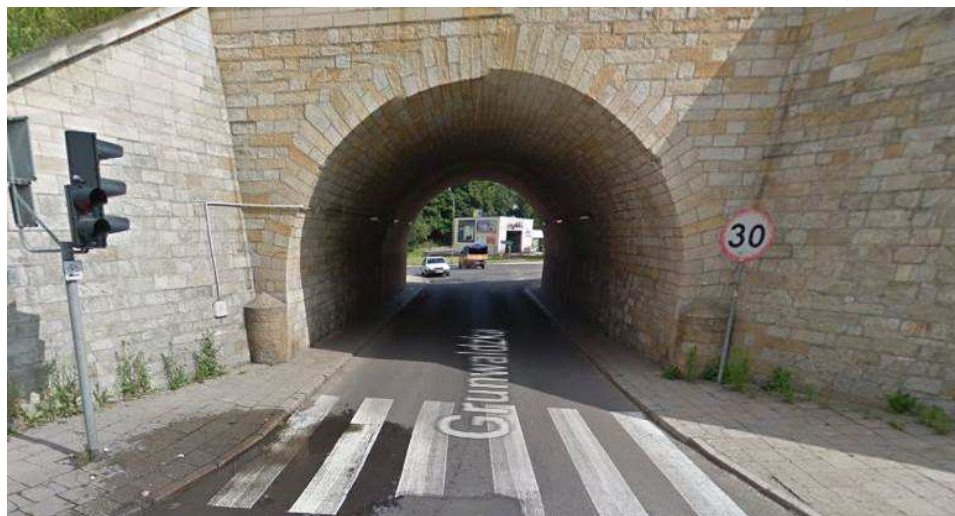
Rys. 15 Skrzyżowanie z ul. St. Staszica , źródło: https://www.google.pl
